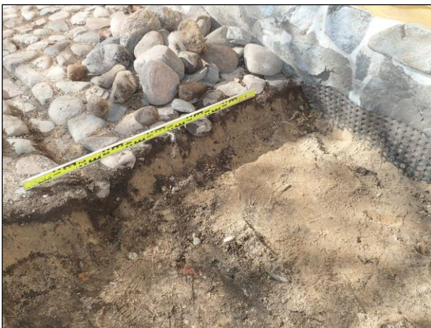
Alla vas: ajettua hiekkaa ja suojakangas tai -matto rakennuksen seinustalla. Oikealla: vanhaa, esiin kaivettua kenttäkiveystä (vas.) ja rännin alle asennettu moderni kiveys. Rännin vieressä näkyy kaapelia, jonka asentamisen yhteydessä vanhaa kenttäkiveystä on rikottu. Kuva luoteeseen.
