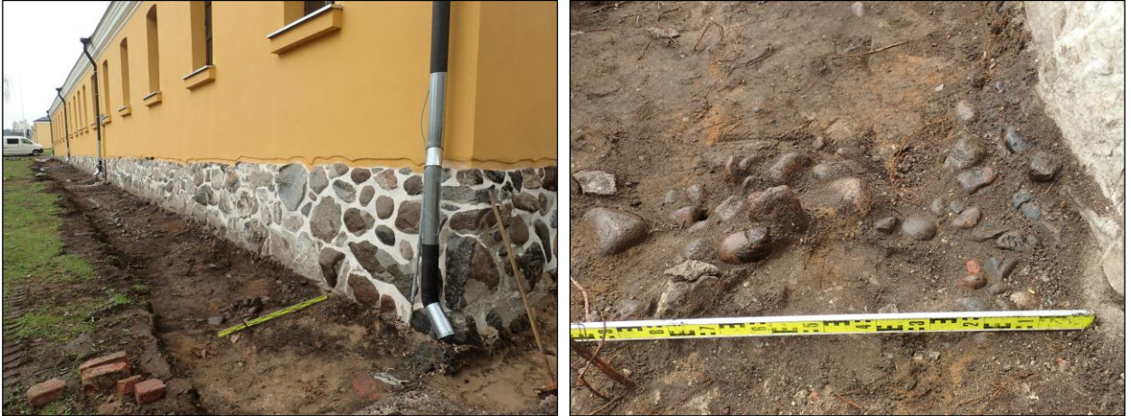
Vasemmalla: Kenttäkiveyksen säilyneet osat paljastettuina. Etualalla kiveys 3. Kuva etelälounaaseen. Kenttäkiveyksen vähäinen jäännös tai sen keskeneräiseksi jäänyt osa. Kuva etelään.
