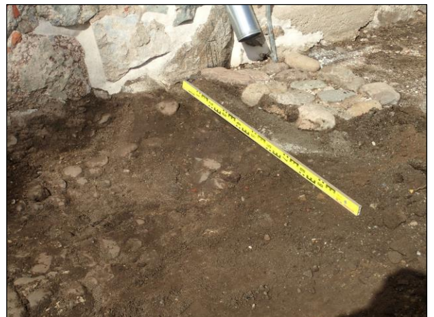
Alla vas: ajettua hiekkaa ja suojakangas tai -matto rakennuksen seinustalla. Oikealla: vanhaa, esiin kaivettua kenttäkiveystä (vas.) ja rännin alle asennettu moderni kiveys. Rännin vieressä näkyy kaapelia, jonka asentamisen yhteydessä vanhaa kenttäkiveystä on rikottu. Kuva luoteeseen.
