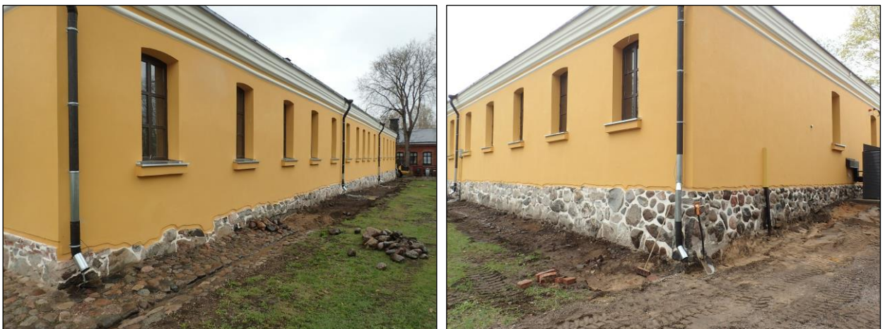
Vasemmalla: maa-aines kuorittuna rakennuksen itäisivulta uuden kiveyksen asentamista varten. Kuva luoteeseen. Oikealla: rakennuksen itäseinustan vanhaa kenttäkiveystä (vas.). Pohjoisseinustalla on ajettua hiekkaa uuden kiveyksen asennussyvyyttä syvemmälle. Kuva lounaaseen.
